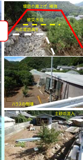
河床掘削や堤防の高上げなどに より浸水被害を解消
