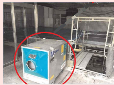
集塵機を設置し室内の換気を実施
