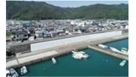
海岸堤防の耐震補強状況
