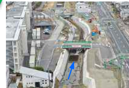
宇治川 (堤防整備)
