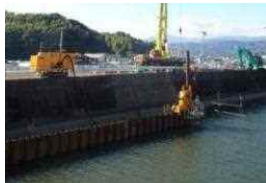
河川堤防の耐震対策
