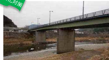
国道381号 窪川橋
