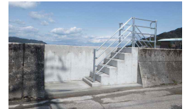
コンクリートによる陸こうの閉鎖
