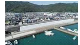
海岸堤防の耐震補強状況
