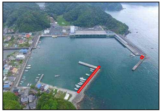
田ノ浦漁港 防波堤の粘り強い化整備
