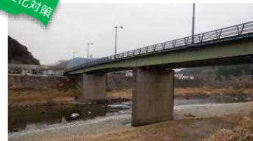
国道381号 窪川橋
