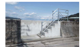
コンクリートによる陸こうの閉鎖
