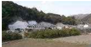
急傾斜崩壊対策事業
