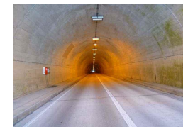
歯朶ノ浦トンネルの状況
