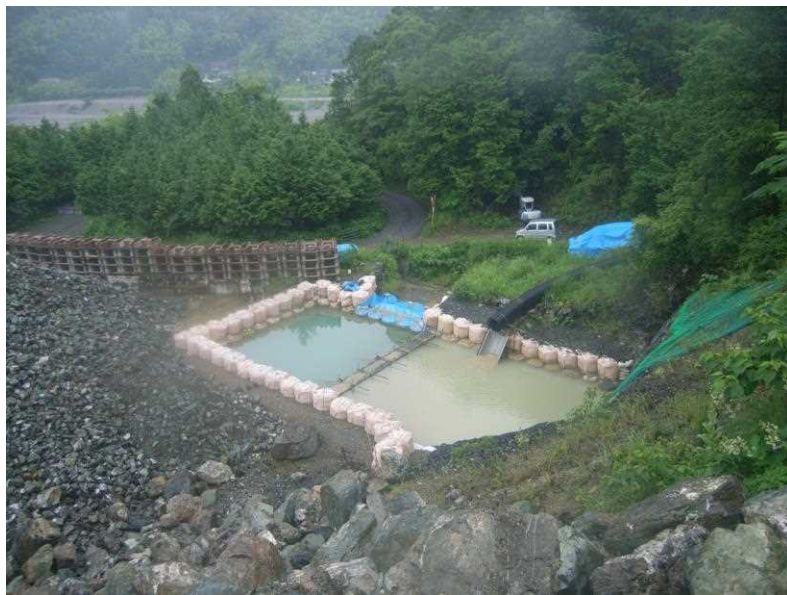
沈砂池のイメージ (エコサイクルセンターを整備した際の事例)
