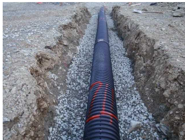
底面に設置する管（例）
