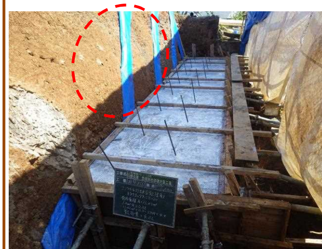
斜面に設置する面状排水材（例）
