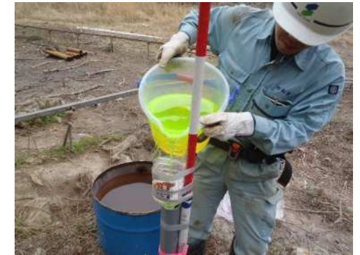
トレーサー投入状況
