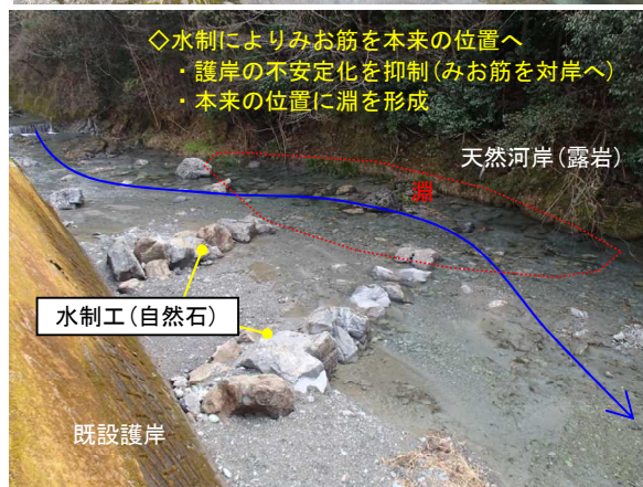
水制設置箇所(工事完了直後)
