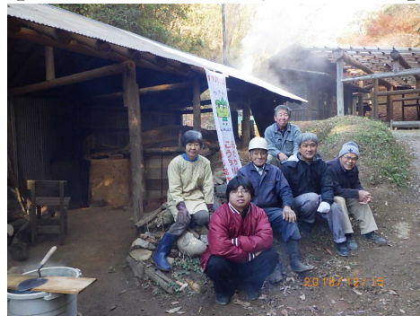
【炭窯修繕研修の様子】
