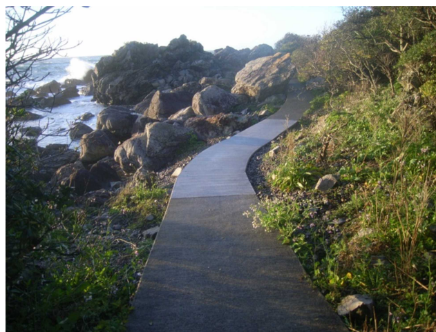
室戸岬園地遊歩道災害復旧工事
