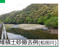
堆積土砂撤去例(松田川)
