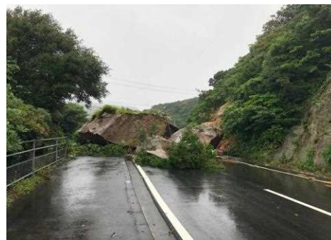
大月町 県道への落石によって住民が孤立
