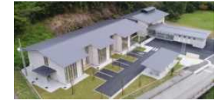
CLT建築物(県立林業大学校)
