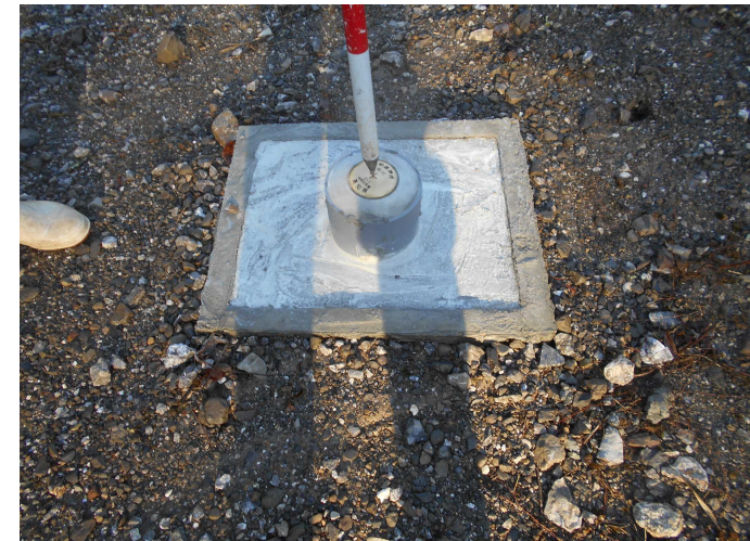
測量に必要な基準となる点の設置状況
