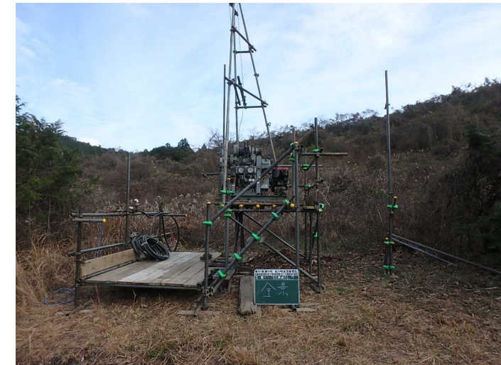
ボーリング機械の設置状況
