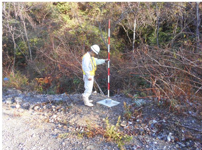
測量に必要な基準となる点の設置状況
