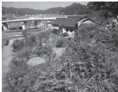
旧須崎職員住宅（大間西町）231-1
