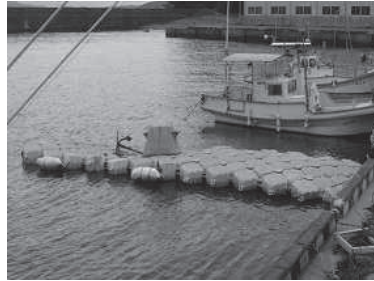
回頭泊地にある仮設栈橋
