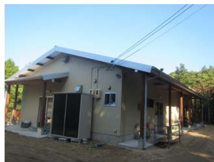
○(株)足摺農園加工処理施設 H30.5稼働開始 地域AP No.3 H29年度産振補助金
