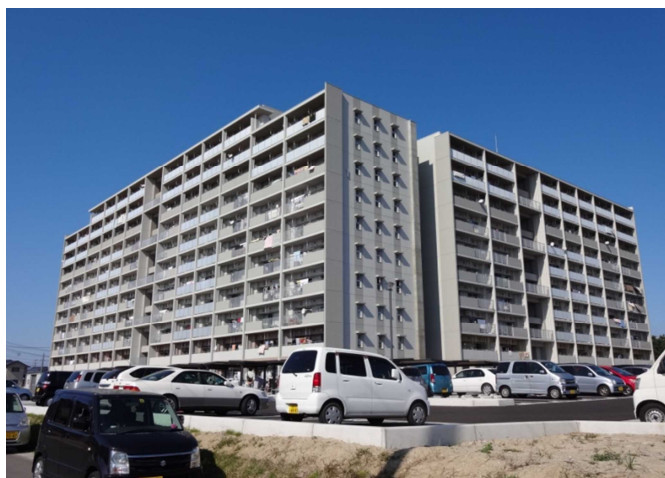
宮城県仙台市の RC 造の災害公営住宅 (市直接建設)
