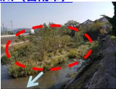
氾濫による危険性が特に高い等の区間において、洪水時に通水阻害とならうる樹木の伐採を行い、河道断面を確保する。
