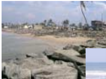
沿岸部の被災状況(バナドゥラ)
