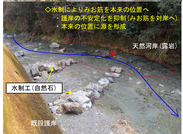
水制設置箇所(工事完了直後)
