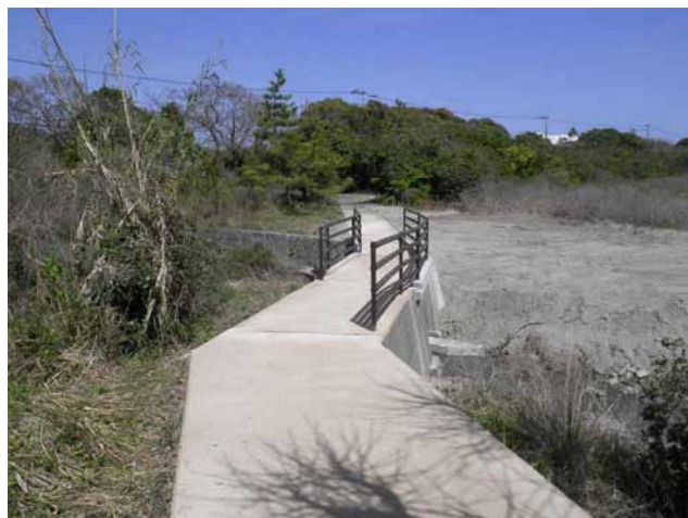
竜串園地遊歩道改修工事
