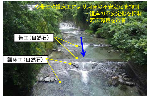
帯工設置箇所(工事完了6か月後)
