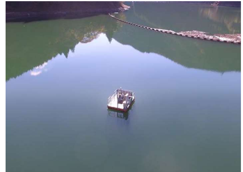
▲自動濁度計 全景
