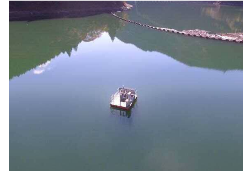
▲自動濁度計 全景
