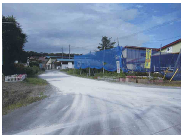
消石灰帯の設置
