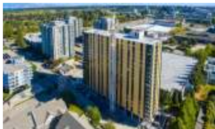
カナダ(学生寮) ・Brock Commons 18階建
