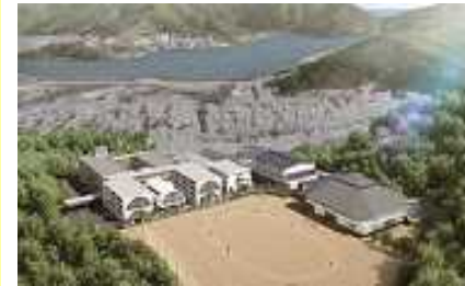
北西側からの全景
