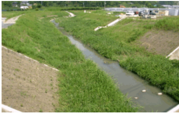
工事完成から5ヵ月後の状況
