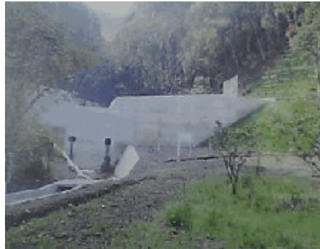
全景(施工後) 下流より
