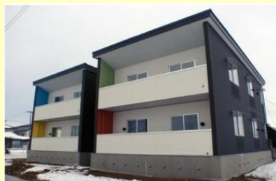
用途 : 集合住宅 CLT部分 : 床、壁、屋根 所在地 : 福島県河沼郡湯川村 写真撮影 : 会津土建(株)
