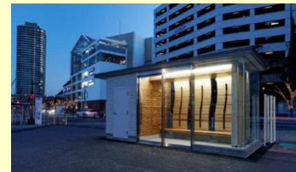
用途 : バス停(休憩所) CLT部分 : 壁、屋根 所在地 : 兵庫県神戸市 写真提供 : 日本CLT協会
