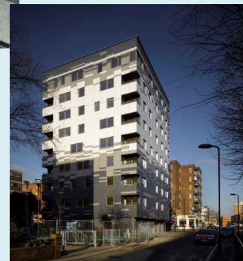
集合住宅(9F:1FはRC) (イギリス ロンドン)
