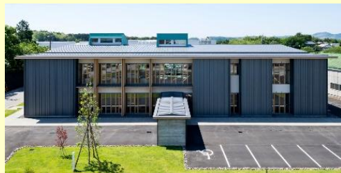
用途 : 事務所 CLT部分 : 床、壁、屋根 所在地 : 高知県南国市 写真撮影 : ふつう合班
