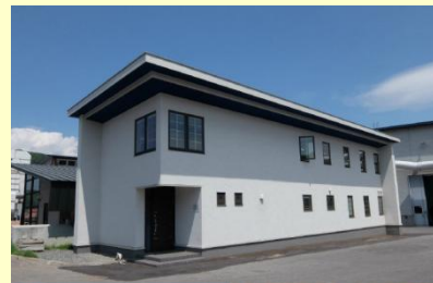
用途 : セミナーハウス CLT部分 : 壁、2階床、屋根 所在地 : 北海道北見市 写真撮影 : 協同組合オホーツクウッドピア
