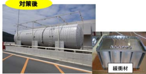
竜巻防護対策設備 (例:重油タンクの防護(緩衝材))
