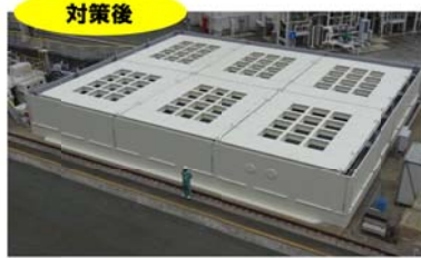
竜巻防護対策設備 (例:海水ピットポンプ室防護壁)
