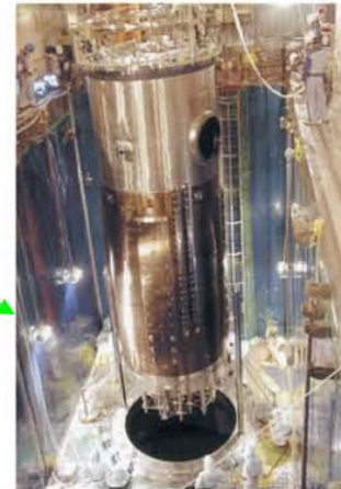
1号機原子炉容器炉内構造物取替工事
