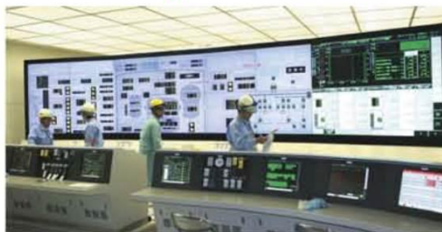
1,2号機中央制御盤等取替工事
