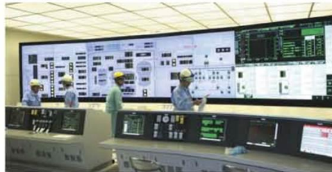
1,2号機中央制御盤等取替工事
