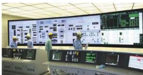
1,2号機中央制御盤等取替工事
