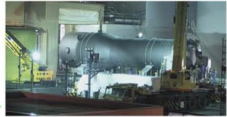
2号機蒸気発生器取替工事
