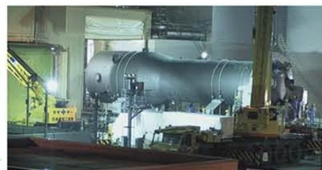
2号機蒸気発生器取替工事
