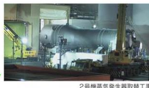
2号機蒸気発生器取替工事
