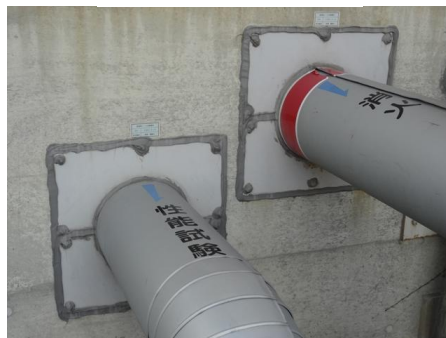
外壁配管貫通部の防水シール加工
