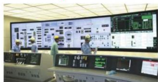
1,2号機中央制御盤等取替工事
