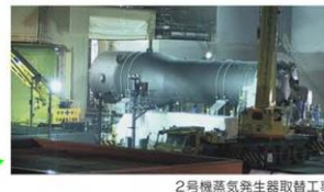
2号機蒸気発生器取替工事
