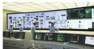
1,2号機中央制御盤等取替工事
