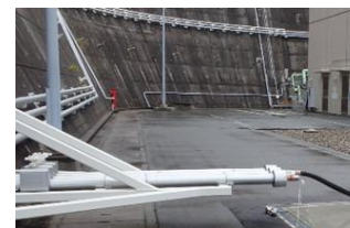
非常用ディーゼル発電機等に用いる重油、および電源車等に用いる軽油の円滑な補給のため、移送配管の設置やミニローリーを配備
