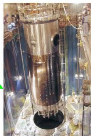
1号機原子炉容器炉内構造物取替工事
