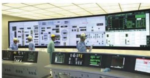
1,2号機中央制御盤等取替工事
