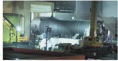
2号機蒸気発生器取替工事
