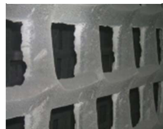
EP内部(点検前)
