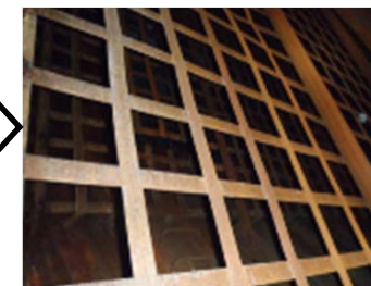
EP内部(点検後)
