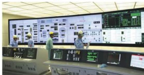
1,2号機中央制御盤等取替工事
