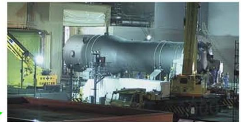
2号機蒸気発生器取替工事
