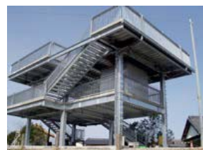
〔津波避難タワー〕
