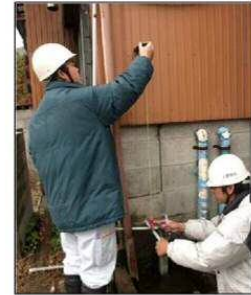
(住宅の傾斜の計測)
