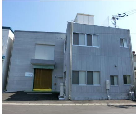
設備投資の補助金により新築した社屋
