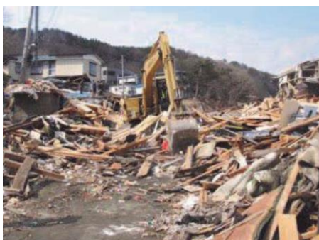
(左)岩手県内の道路啓開の様子
