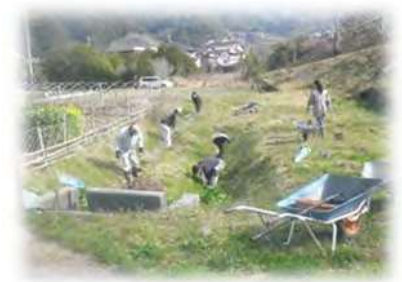
水路の泥上げ
