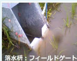
流出を抑制する落水量調整装置の例
