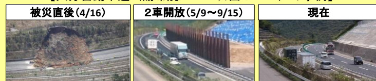
【大分自動車道(湯布院IC～日出JCT)の事例】
