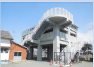
●津波避難タワー
