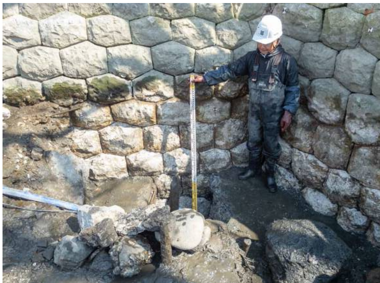
写真5 TR4 コンクリート除去後掘削状況
