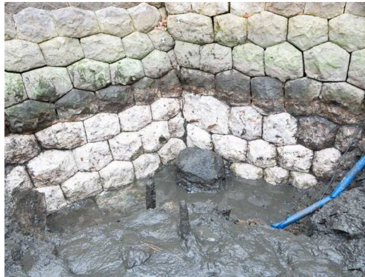
写真4 TR4 掘削時石垣状況
