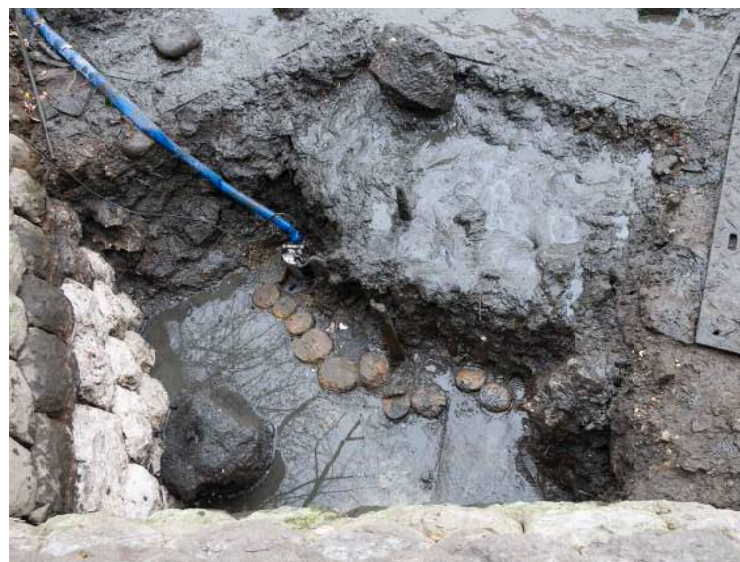
写真3 TR4 コンクリート・丸太杭検出状況
