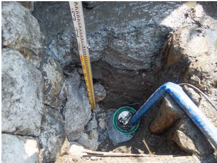
写真6 TR4 コンクリート除去後掘削状況 近景
