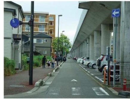
高架橋と側道
