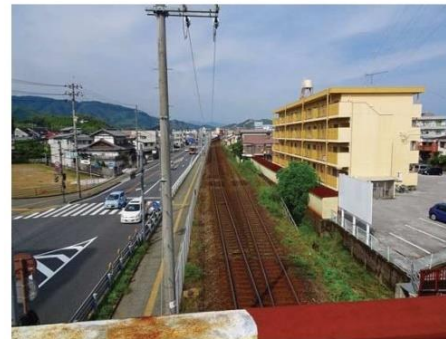
行違設備 (荊野駅付近)
