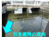
新堀水門南側：測線⑤付近 工事が完了した水門南側の新堀 川導水路内に生育。 引き潮時の流向に沿って三角形 に分布。 密度は新堀橋周辺に比べてまばら。
