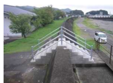
コンクリートによる陸こうの閉鎖
