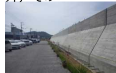
海岸堤防の耐震補強状況
