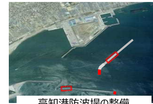
高知港防波堤の整備
