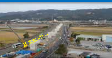
高知東部自動車道 高知南国道路（高知市）
