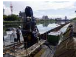
河川堤防の耐震補強状況
