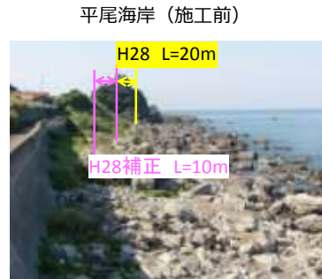
平尾海岸 (施工前)
