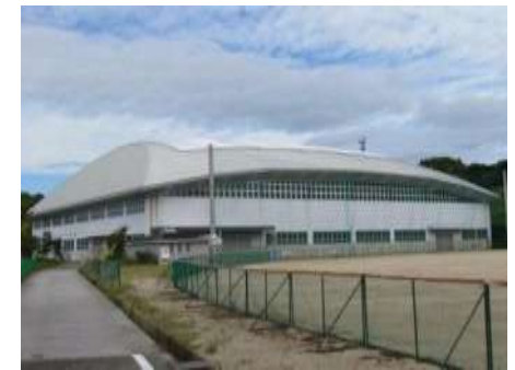
春野総合運動公園 屋内運動場
