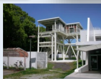
<津波避難タワー>
