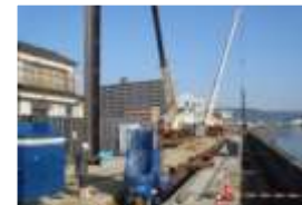
(耐震工事状況)
