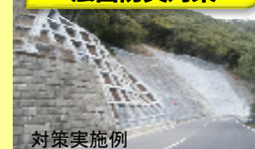
法面防災対策
