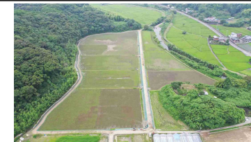
【加持地区(黒潮町) ほ場整備】
