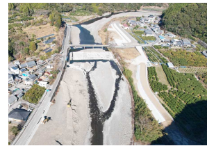
【安芸川】 (河川の堤防整備)
